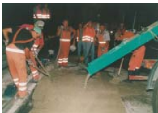
Einbringen des Betons
