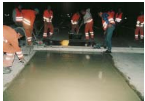
Abziehen und Verdichten
