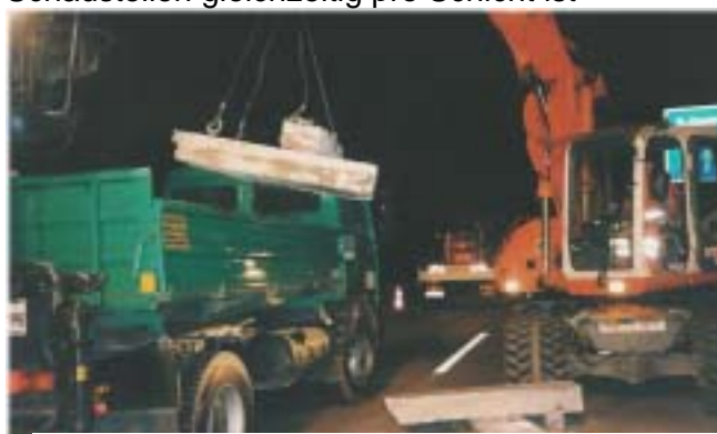
Ausheben der Platten
