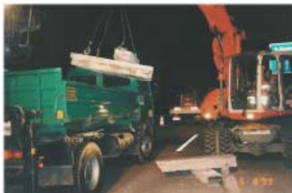
Ausheben von Platten
