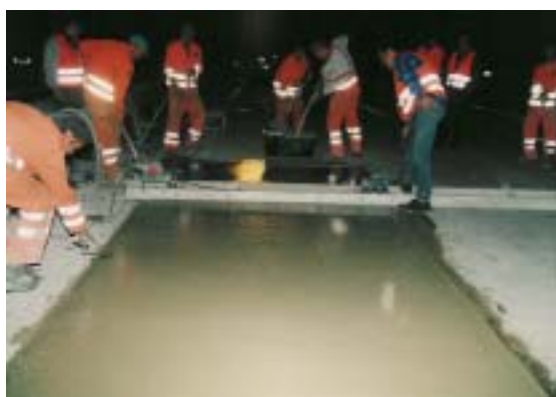
Abziehen und Verdichten
