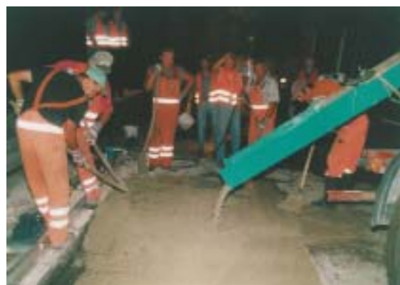
Einbringen des Betons
