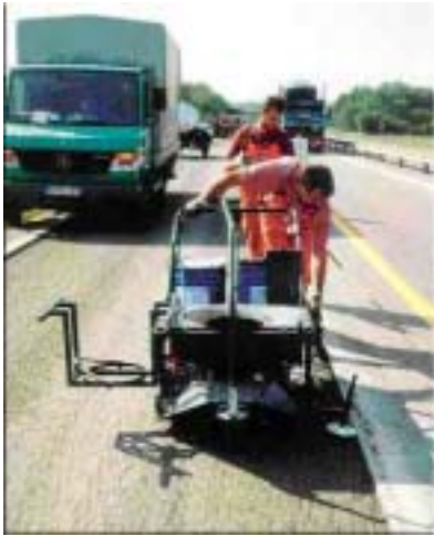
Aufbringen von Kaltbitumen
