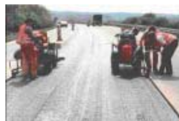
Maschinelles Anbringen bitumenhaltiger Fugenbänder
