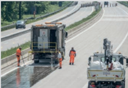
Bild 2: (links) Auftragen des Reaktionsharzes, (rechts) Abstreuen
