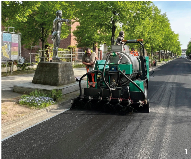
1 Onyxauftrag | 2 fertige Oberfläche | 3 Düsen-spritzvorrichtung
